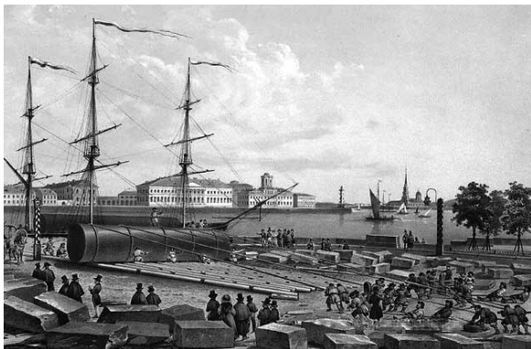
Выгрузка и перекатка колонн. Литография с рисунка О. Монферрана.
