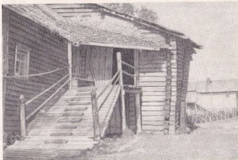
Рис. 19. Вход в дом по взвозу.
