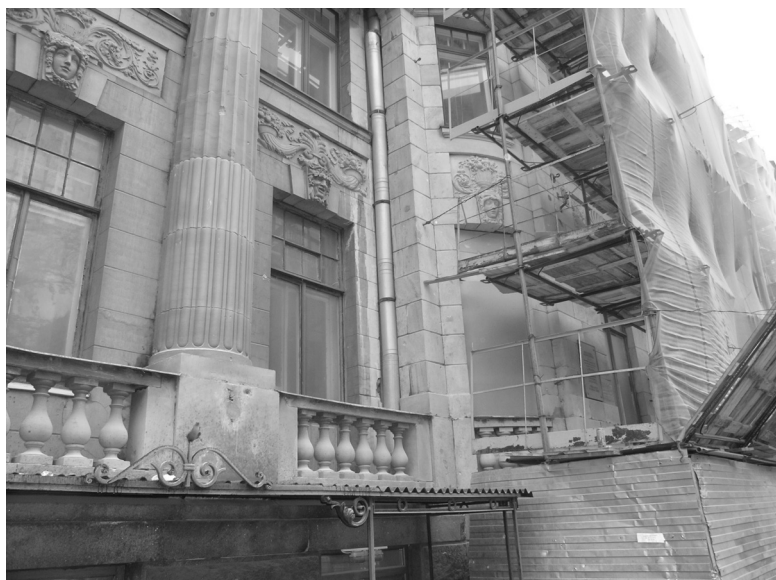
Рис. 1. Здание в Санкт-Петербурге, облицованное тальковым камнем. Дом 26-28 на Каменноостровском проспекте (Построено 1911-1913 г.г., Арх. Л.Н.Бенуа, А.Н.Бенуа, Ю.Ю.Бенуа). Слева от водостока нереставрированный камень, справа – после реставрации
