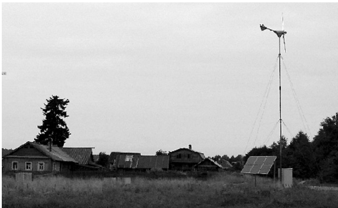
Р и с . 4 . Комбинированная ветроэнергетическая и солнечная установка (фото М. С. Богдановой) Fig . 4 . Integrated wind power and solar energy installation (photo by M. Bogdanova)
