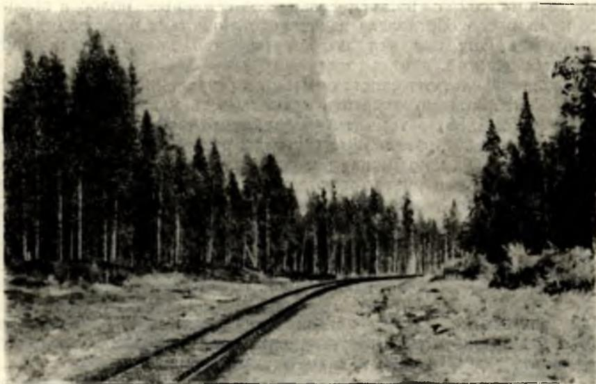
Рис. 2. Снегозащитно-семенная полоса.
