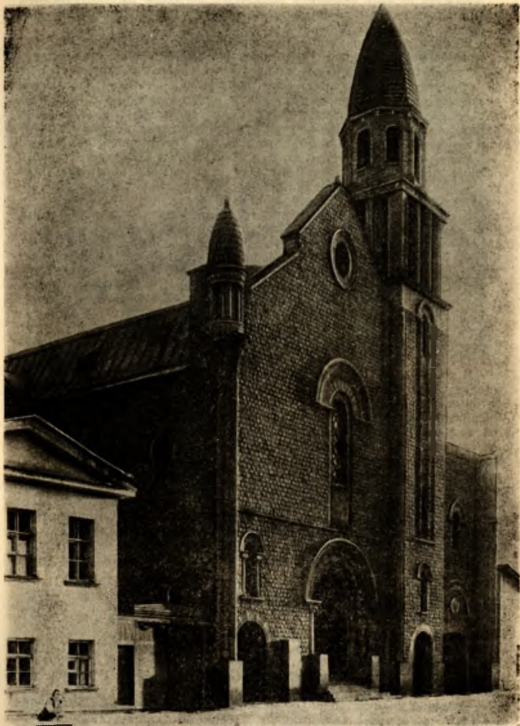
Рис. 2. Облицовка из брусчатки серого сердобольского гранита. Французский костел в Ленинграде
