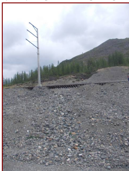
Рис. 1 – Результаты выноса материала насыпи водокаменным селем. Железнодорожный путь висит в воздухе (снимок сделан снизу, с притрассовой автомобильной дороги)
