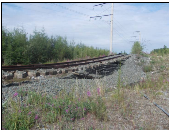
Рис. 2 – Просадка основания насыпи, обусловленная вытаиванием подземных льдов
